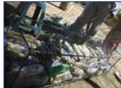
La banca necesita hierro, malla metálica y repello.
